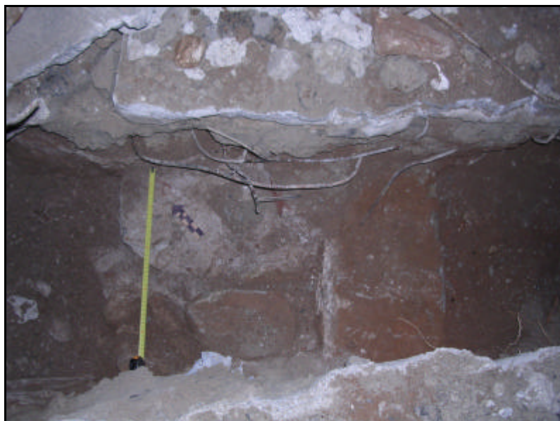
Fotografia 33: Planta mur U. E. 417
