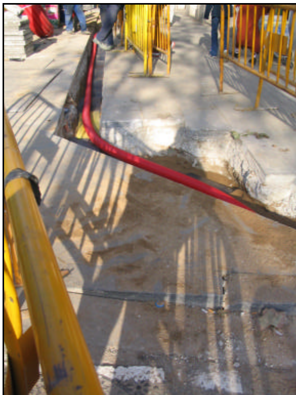
Fotografia 42: Col·locació tubs Rasa 7
