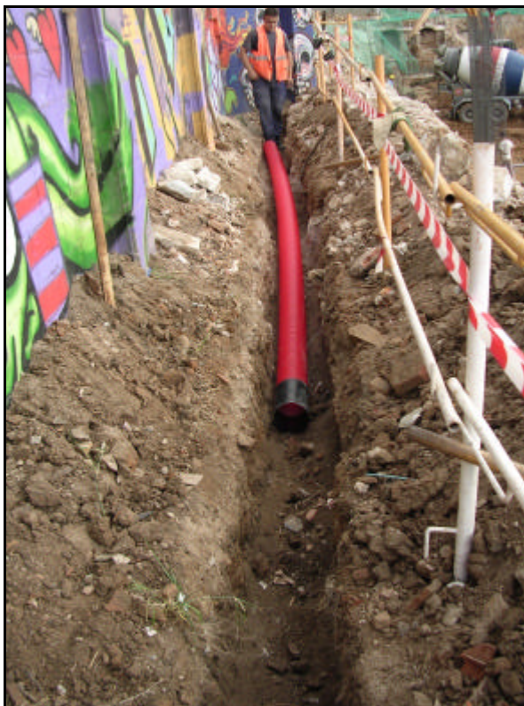
Fotografia 24: Col·locació tubs a la Rasa 1
