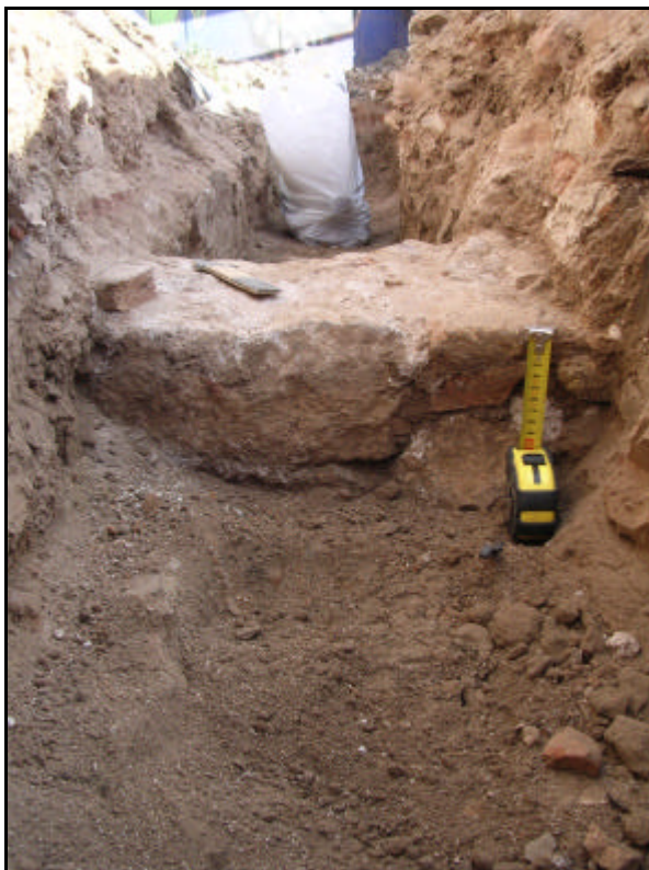
Fotografia 16: Alçat mur U. E. 128, orientació NW-SE
