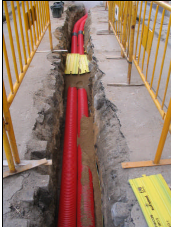
Fotografia 40: Col·locació tubs Rasa 6
