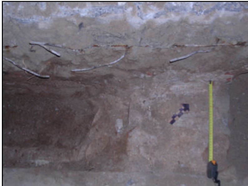
Fotografia 32: Planta mur U. E. 415
