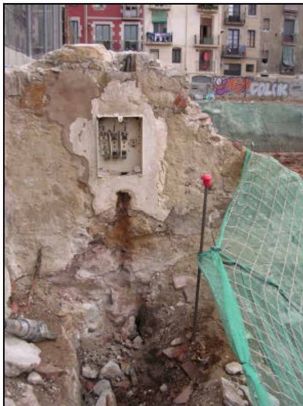
Fotografia 12: Alçat mur U. E. 122, orientació NW-SE
