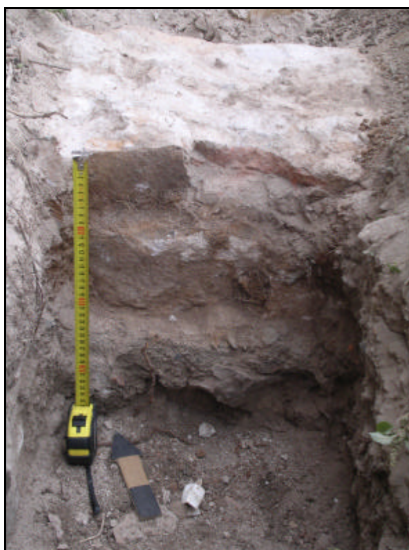
Fotografia 12: Alçat mur U. E. 120, orientació NW-SE
