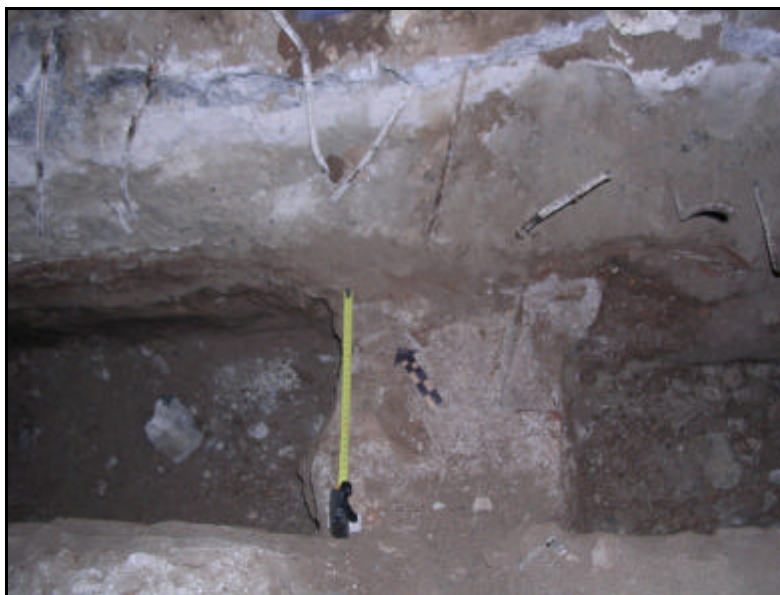
Fotografia 34: Planta mur U. E. 419
